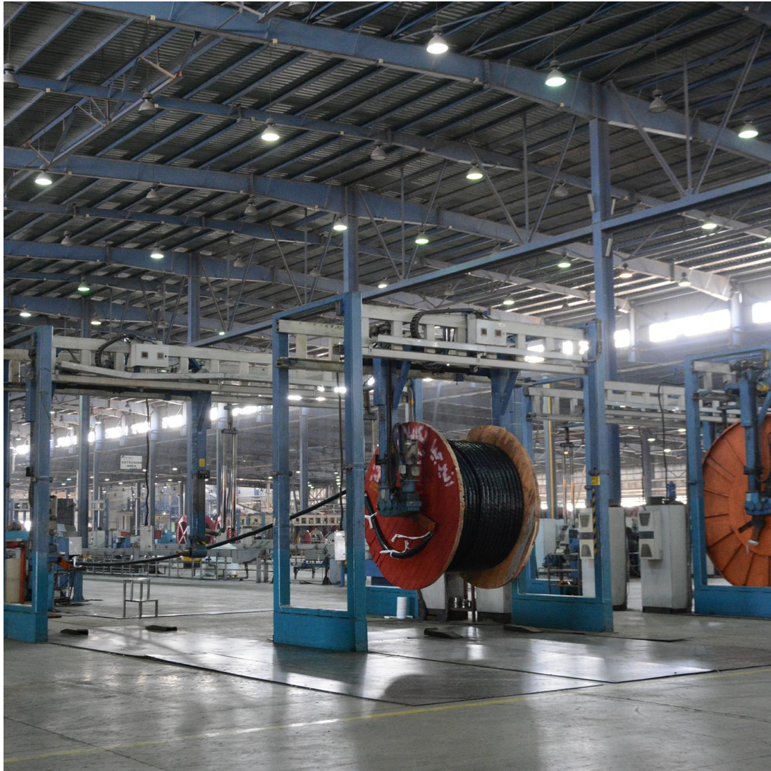
Egipt – od 1988 roku, kable od nn do EHV (220kV)
