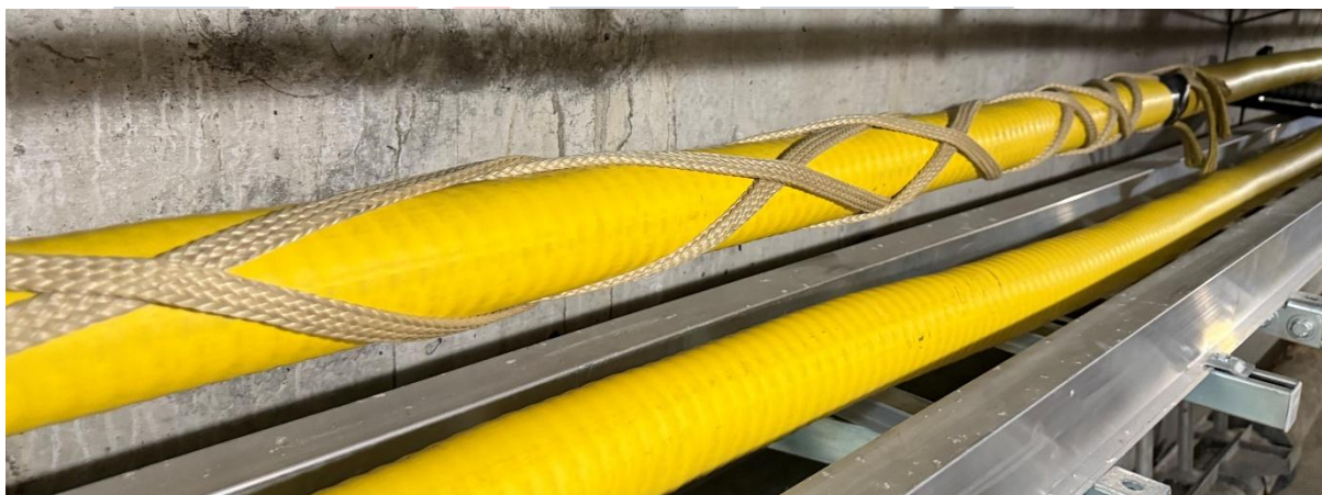
Rys. 10. Przykład założenia klaczonego ogona na kabel typu MC-HL
