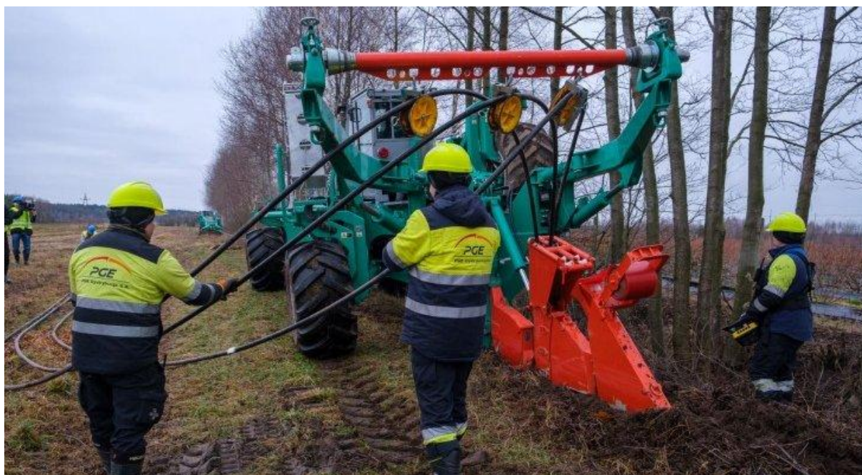
Rys. 1. Przykład realizacji układania metodą płuzenia [1]
