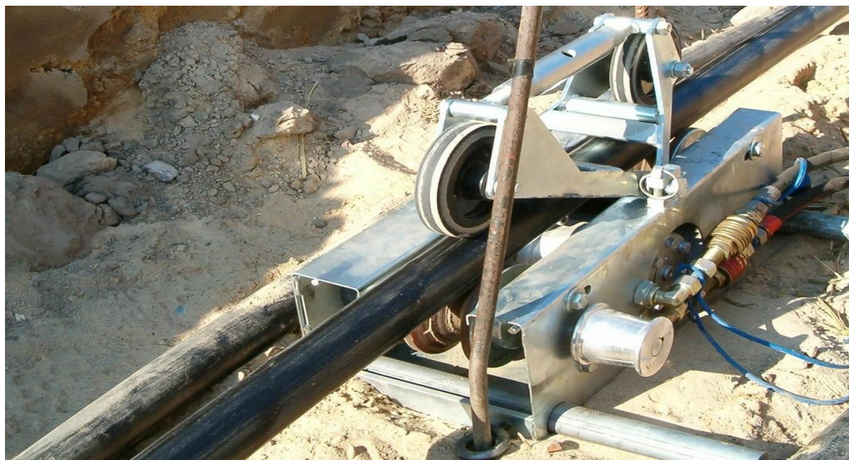
Rys. 8. Przykładowy wygląd pieska kablowego podczas pracy [9]
