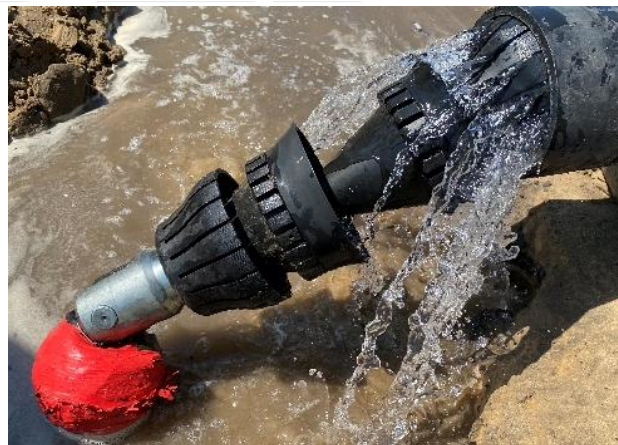
Rys. 5. Wodoszczelny tłoczek wywołujący ciśnienie wody w rurze kablowej
