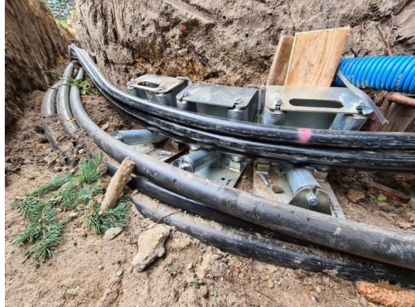
Rys. 3. Zastosowanie rolek kątowych na załomie trasy [3]
