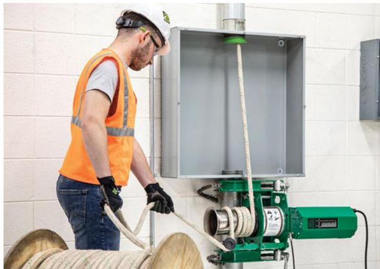
Rys. 9. Assist tugger na mocowaniu łańcuchowym [10]
