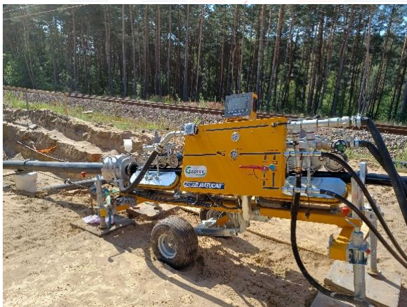
Rys. 4. Pompa doprowadzająca wodę do głowicy przed wejściem do rury kablowej
