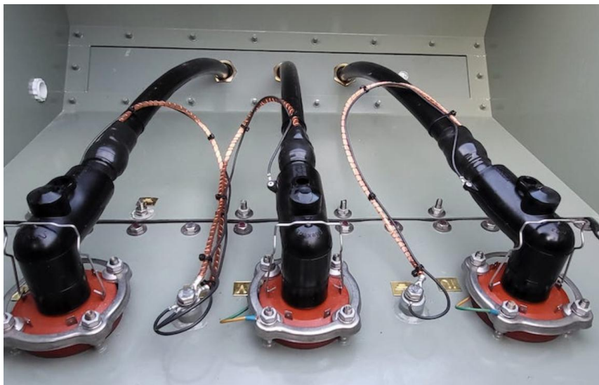
Rys.4 Kątowe głowice kablowe SN, przed instalacją na przepustach rozdzielni
