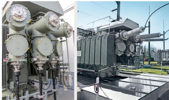
Rys.16 Transformator mocy wyposażony w gniazda systemu konektorowego po stronie pierwotnej, podłączony z lewej kablowo, z prawej napowietrznie przez głowicę hybrydową „Plugable bushing”
