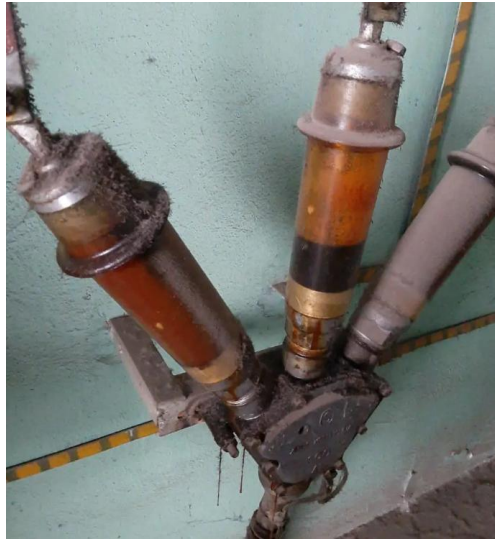
Rys.1 Głowice kablowe na kabel olejowy
